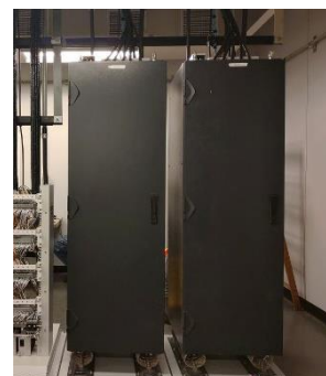
Équipement en bordure de voie CBTC
