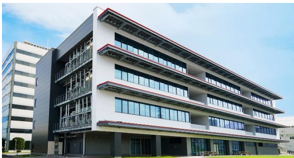
Installation de test de ZEB SUSTIE
